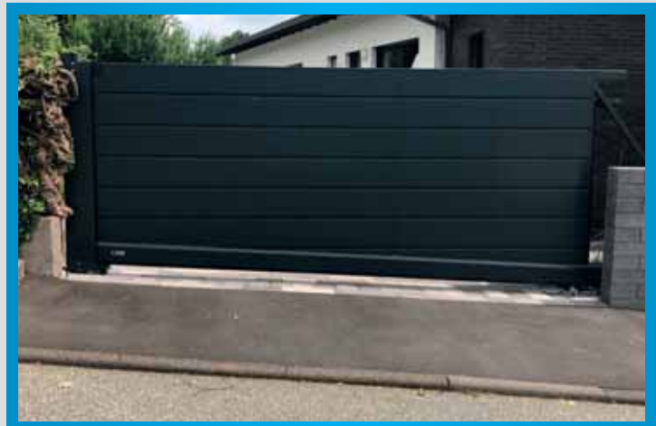
Schiebetor oben waagrecht, unten dem Gefälle angepasst
