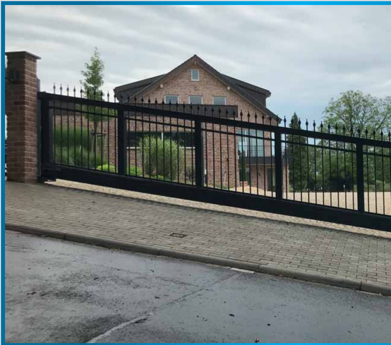
7,50 m Schiebetor, Alu Schmiede Zierspitze „Dekor“, RAL 7016 glänzend, Inline 250, Schrägbau-Gefälle in Öffnungsrichtung 18,30 %
