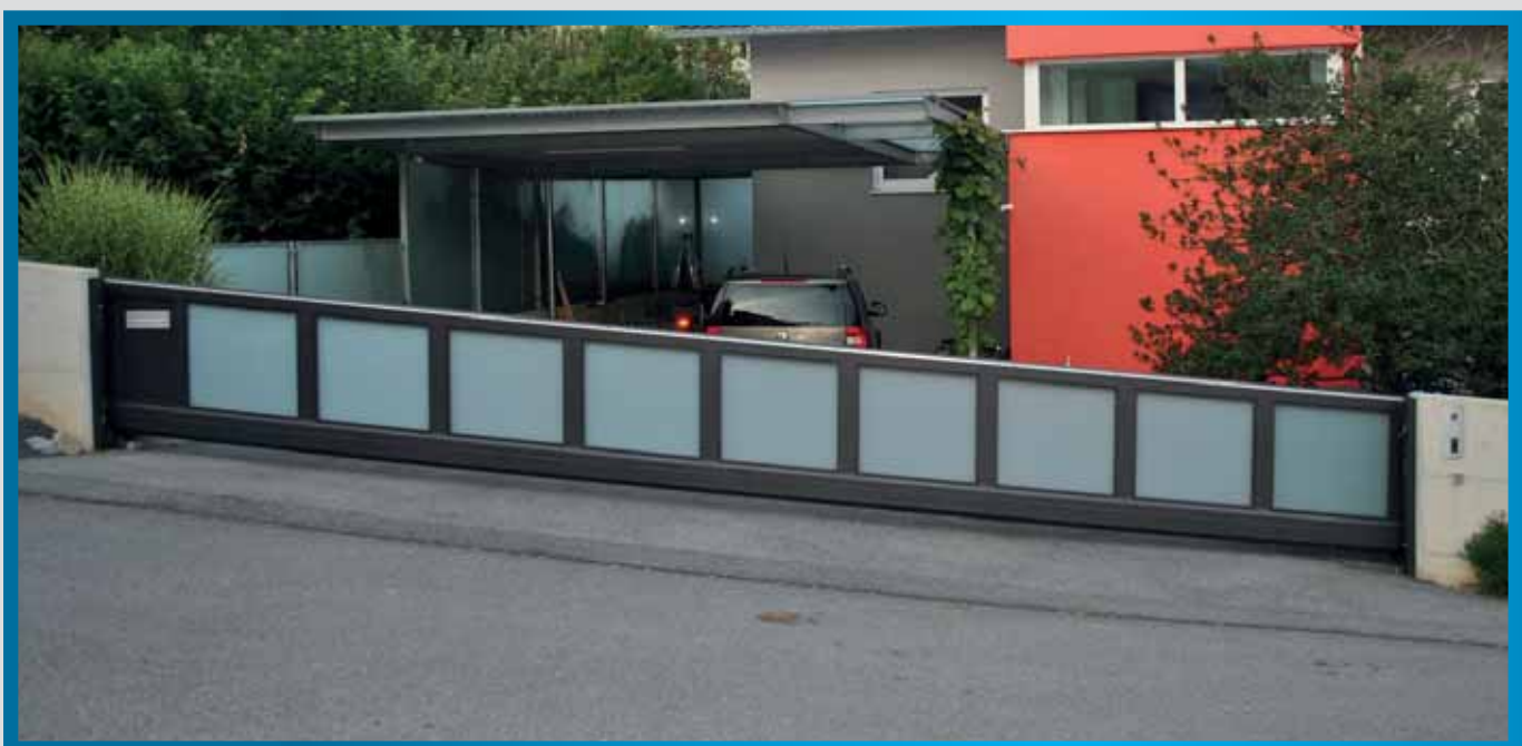
9 m Schiebetor, oben und unten schräg mit 900 mm Höhenunterschied gefertigt, Füllung Milchglas, im Torblatt integrierter Briefkasten mit rückseitiger Entnahme.
