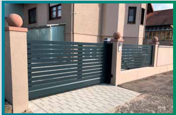
Schiebetoranlage und Zaun Amsterdam 80, Latten von außen vor den Torrahmen gesetzt, RAL 7016
