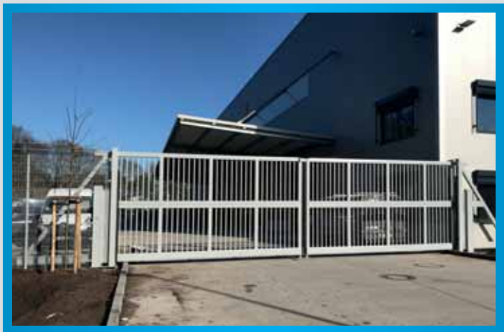
Gegenläufige Schiebetoranlage 2 Stk á 5500 mm Pfostenlichte, 3000 mm Höhe, RAL 9006 S, Inline 120, 1,69% Schrägbau – in der Höhe 2-geteilt
