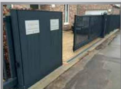
Briefkasten- und Bediensäule als Einlaufzentrale für zwei Schiebetore
