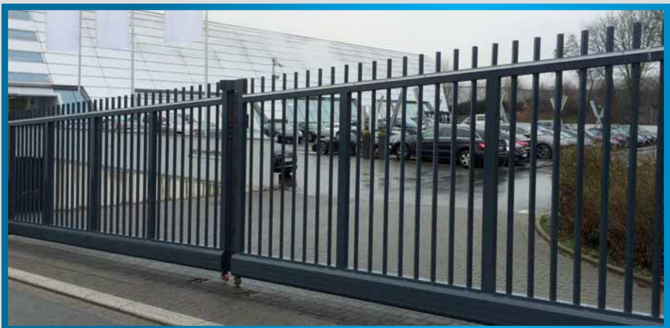
14 m Schiebetor als gegenläufige Anlage, Profil Ø 25 durchgesteckt
