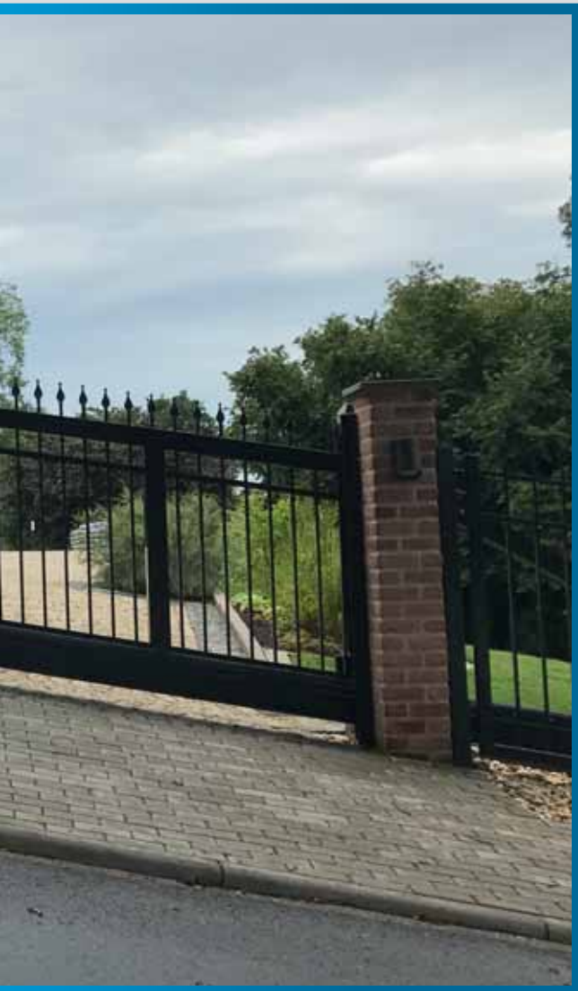
Schiebetor oben waagrecht, unten dem Gefälle angepasst
